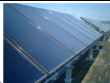
Une chaufferie centrale assure la production d'énergie pour les besoins de chauffage et de production d'eau chaude sanitaire. L'installation solaire avec des capteurs implantés sur la toiture d'un seul bâtiment, a pour objet de se substituer en partie à l'actuelle production d'eau chaude sanitaire utilisant le gaz comme énergie.
